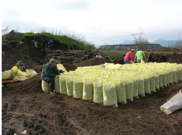
Fotografía N° 8 (gentileza Oficina Maipo, R.M.)
